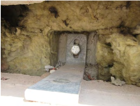
Abbildung 2-6: Rückhaltewinkel P23
