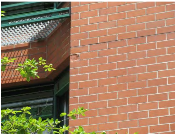
Abbildung 2-1: Abplatzung an Mauerstein
