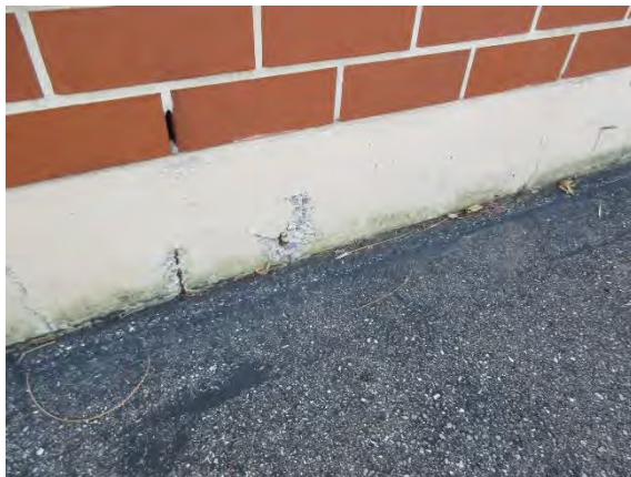
Abbildung 2-17: Abplatzungen aufgrund von Bewehrungskorrosion an der Ostfassade des Krankenhauses
