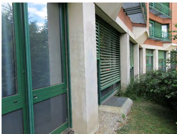
Abbildung 2-21: Ostfassade Wohnheim Verfärbungen aufgrund Bewitterung
