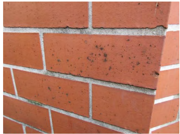
Abbildung 2-2: Mauerstein mit organischem Angriff
