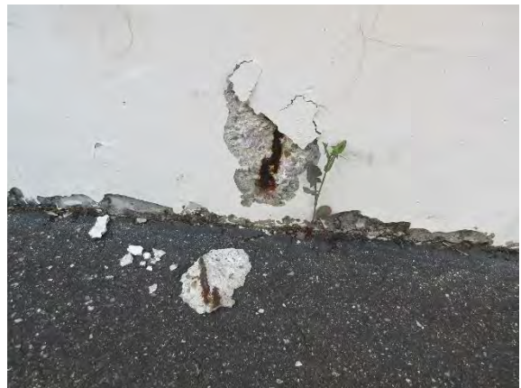
Abbildung 2-18: Abplatzung und Querschnittsverlust der Bewehrung
