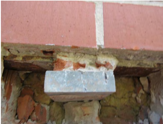
Abbildung 2-7: Tragkonsole K157
