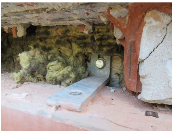
Abbildung 2-4: Rückhaltewinkel K57
