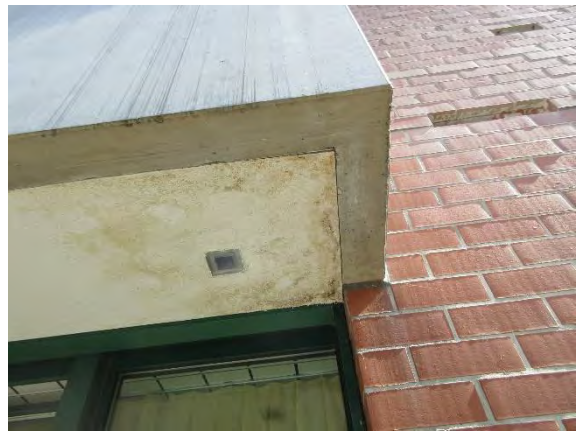
Abbildung 2-16: Wasserschaden an der Balkonunter-sicht
