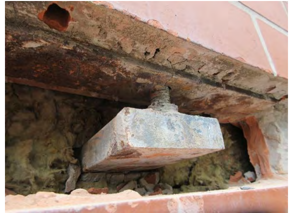
Abbildung 2-8: Tragkonsole K160
