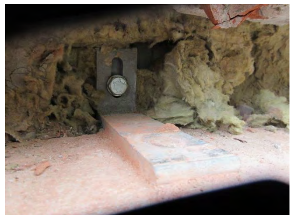
Abbildung 2-5: Rückhaltewinkel K60
