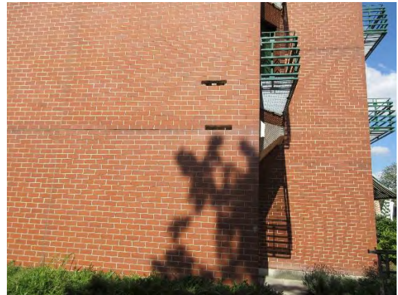
Abbildung 2: Sondieröffnungen K60/160
